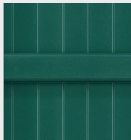
Dettaglio anta vista interna
